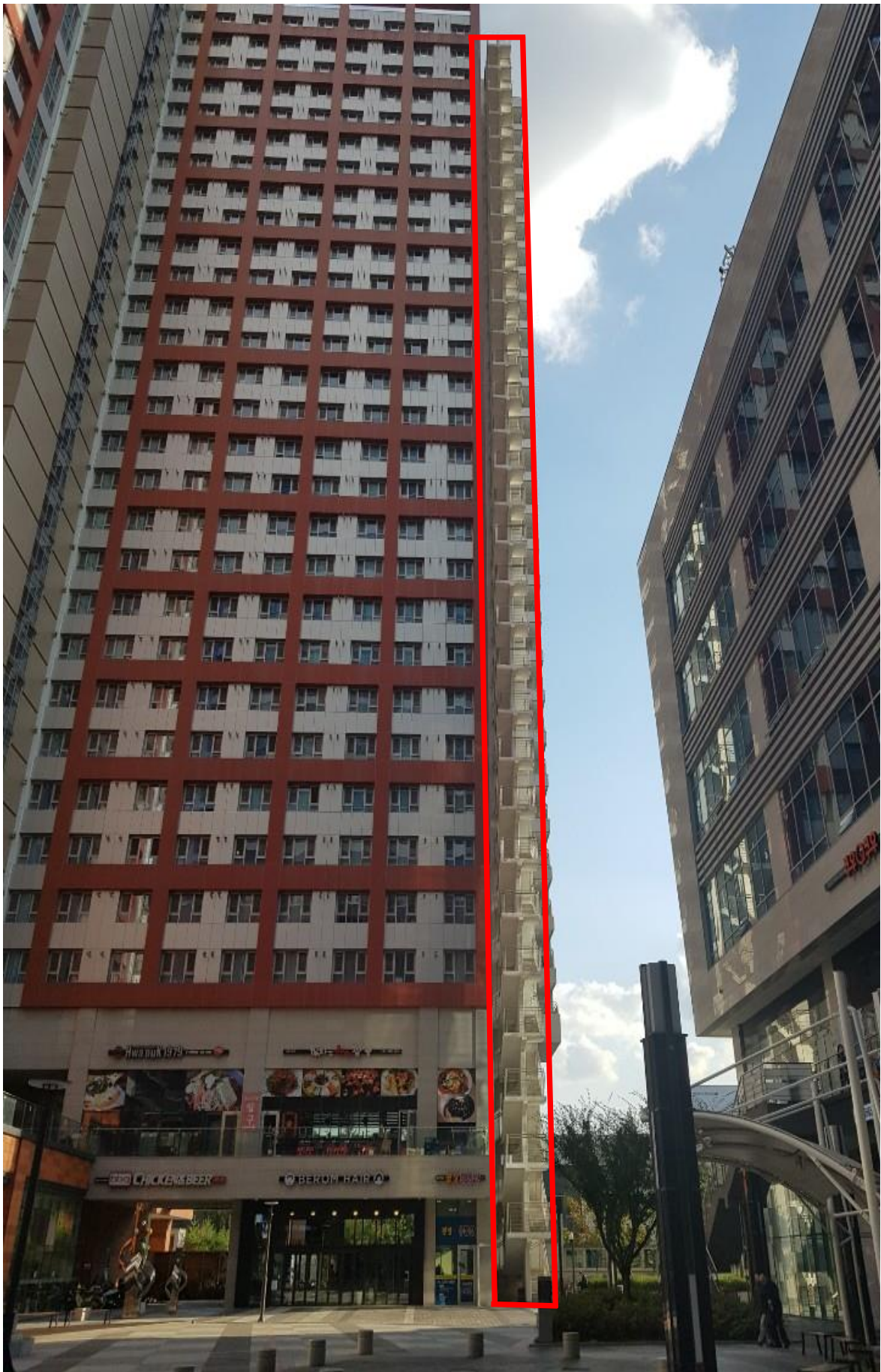
외부계단 전경 사진
